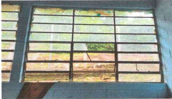
Foto 1. cambio de balcones y vidrios al modulo I
