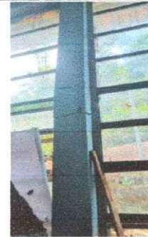
Foto 6. Reforzamiento de columnas de ventanas
