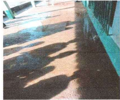
Foto 4. Puestas de canales en todas las caidas de agua del Establecimiento.
