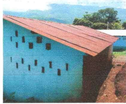
foto. Sustitucion de laminas de la cocina.
