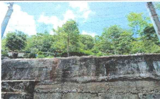
Foto 3. Pintar el muro perimetral del Establecimiento.
