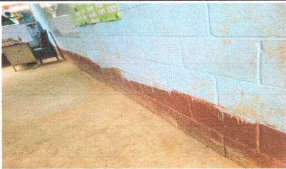
Foto 5. Pintar todas las aulas.
